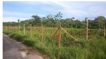
그림 10. 양어장 안전 철조망 설치
