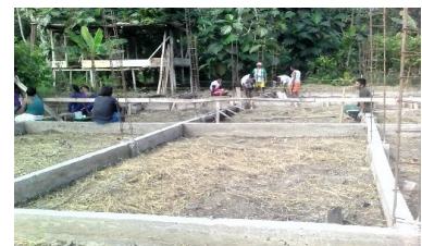
그림 4. 보이후와수 마을교회당 공사
